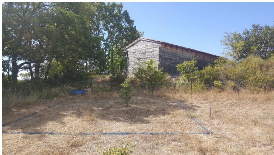
Le bâtiment voisin et l'emplacement du bassin de collecte des eaux de pluie.
